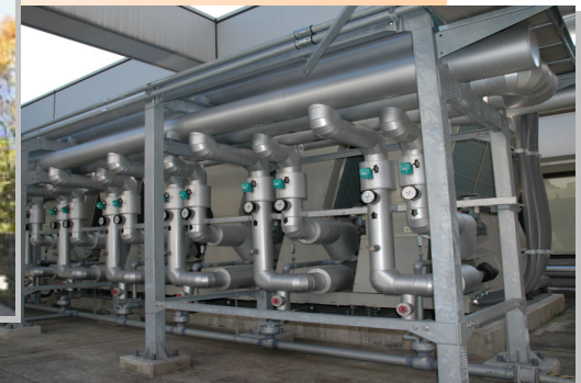
14期取得物件改修工事 15期新設備本格稼動
