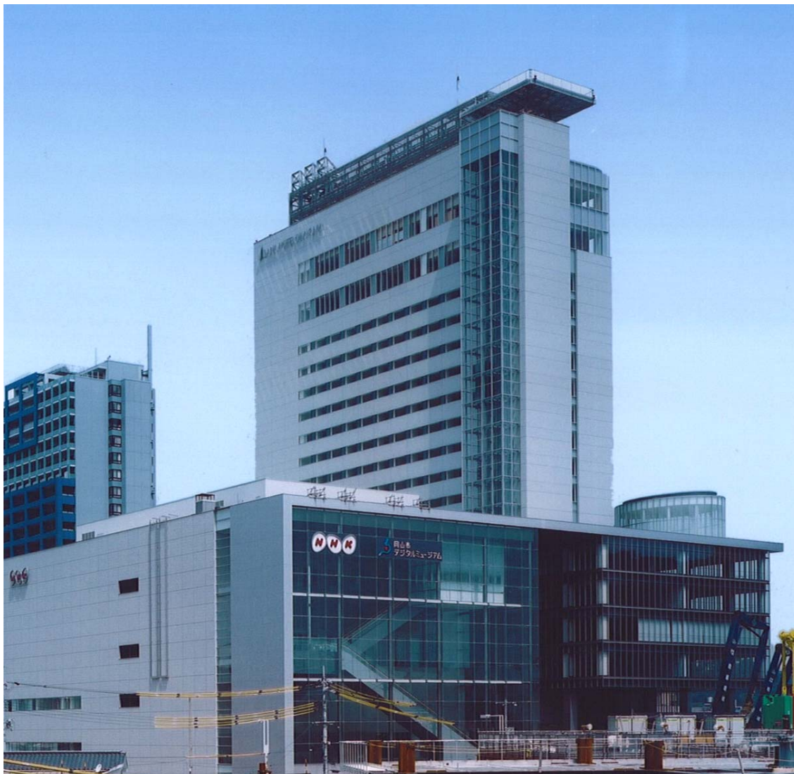
(参考) リットシティビル外観写真
