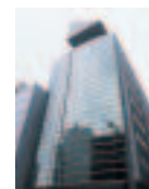
住友電設ビル
