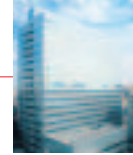
横浜STビル
