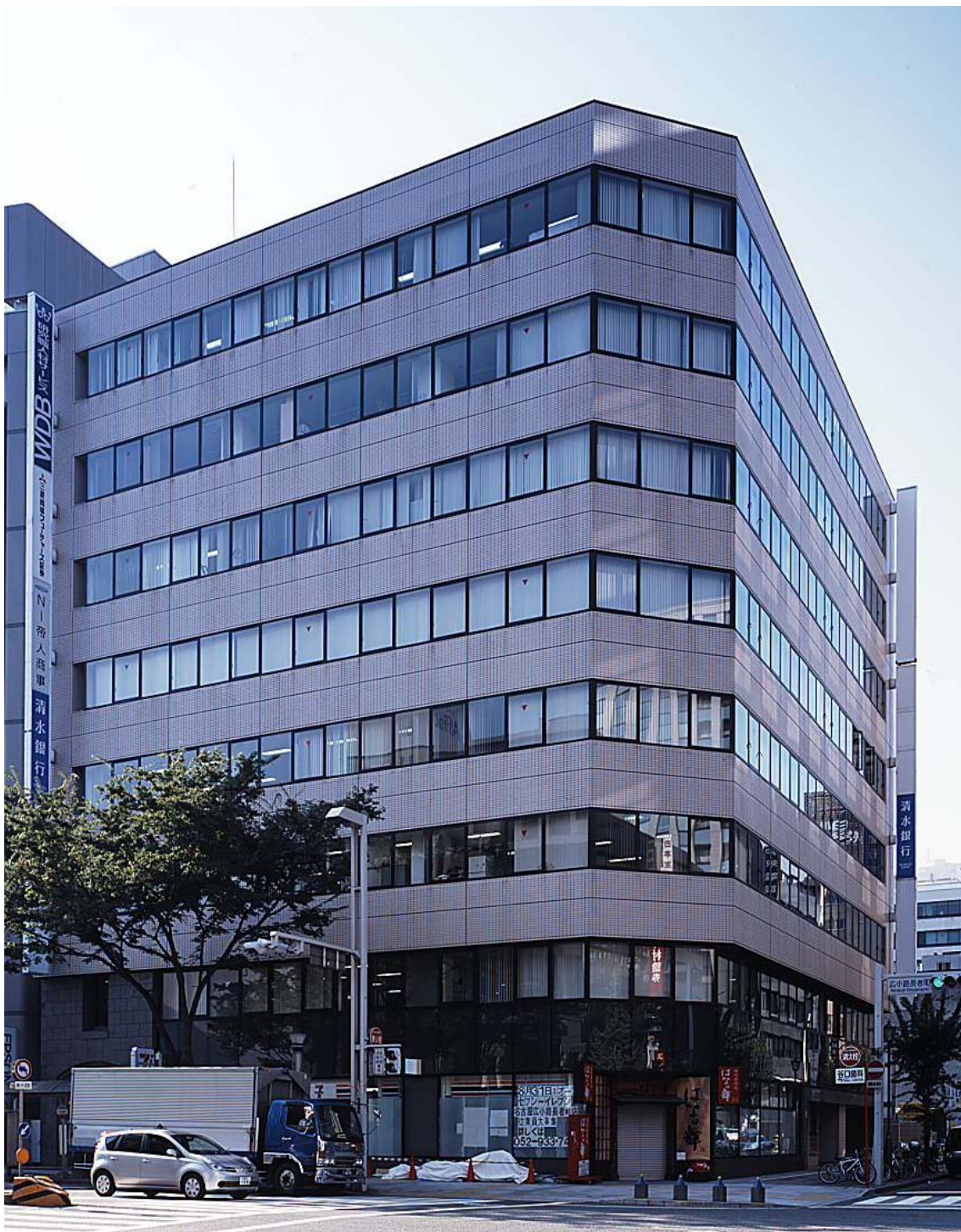
(参考) 広小路東京海上日動ビルディング外観写真
