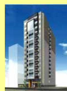
プロシード大阪北堀江（施工中）
