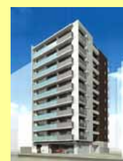
プロシード大阪西天満（施工中）
