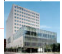
札幌エルプラザ
