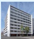
A-53 KDX博多南ビル
