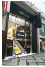
Gビル心斎橋01 (大阪府大阪市)
