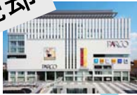
さいたま浦和8953ビル (埼玉県さいたま市)
