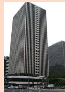
大阪駅前第3ビル [大阪市北区] (区分所有)
