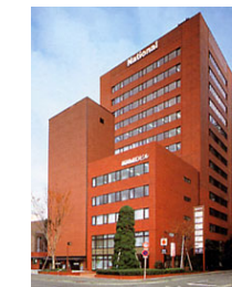
福岡MIDビル [福岡市] ●
