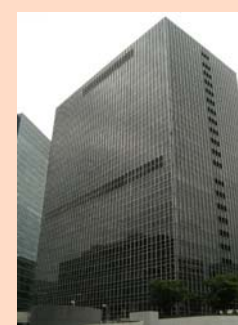
大阪駅前第4ビル [大阪市北区] (区分所有)
