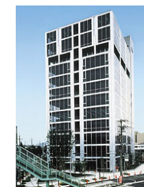
和歌山MIDビル [和歌山市] ●
