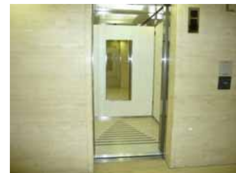
エレベータ内装リニューアル
