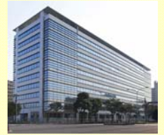
晴海センタービル
