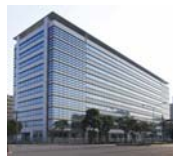
14 晴海センタービル
