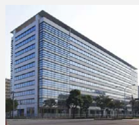
晴海センタービル
