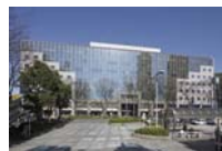
5 武蔵小杉STMビル
