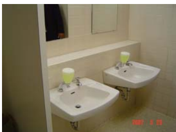
<トイレ(洗面所) : 改修前>
