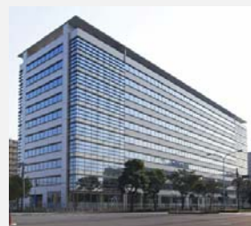
晴海センタービル
