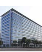
14 晴海センタービル
