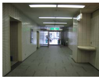
<エントランスホール : 改修前>
