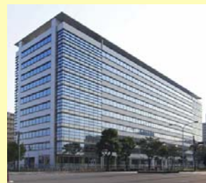
晴海センタービル
