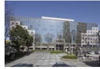
5 武蔵小杉STMビル
