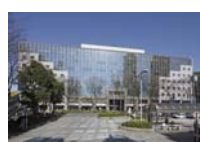
5 武蔵小杉STMビル
