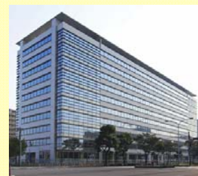
晴海センタービル
