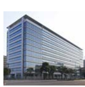
14 晴海センタービル
