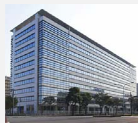
晴海センタービル
