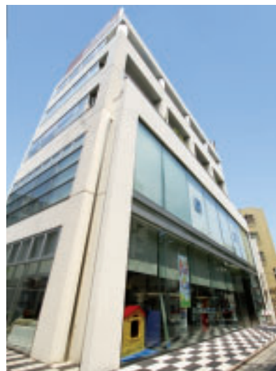
Office 事務所 KN自由が丘プラザ
