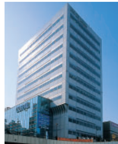
Office 事務所 ネオ・シティ三鷹
