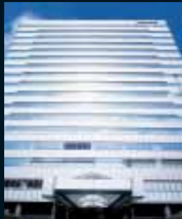
A-4 丸紅大阪本社ビル
