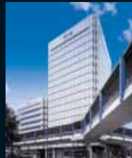
A-5 新横浜TECHビル
