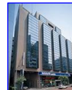
東京日産台東ビル
