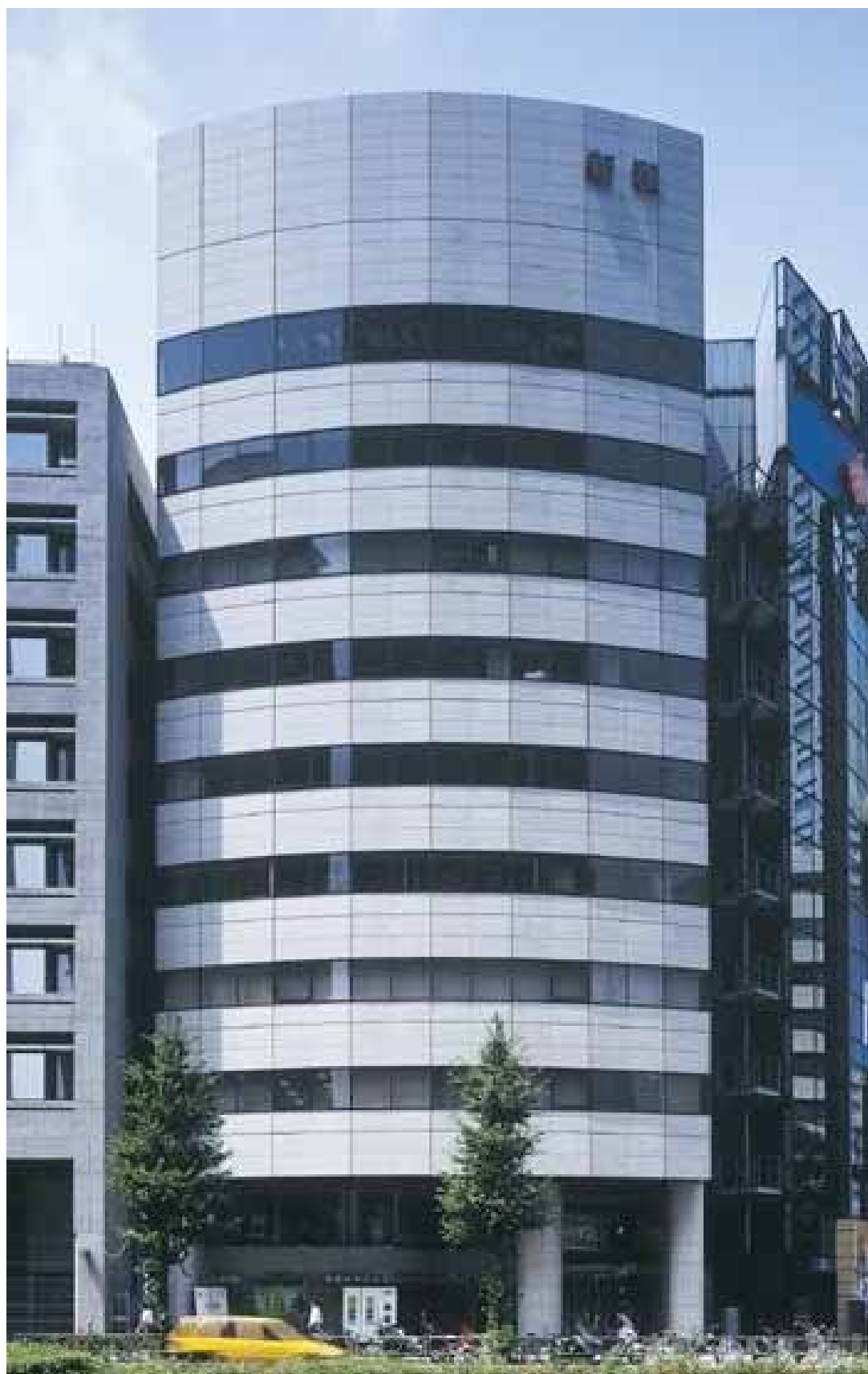
新和ビルディング 外観写真
