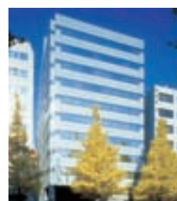
III-3 SENDAI HONCHO HONMA BUILDING 仙台本町ホンマビルディング
