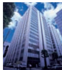
I-9 YURAKUCHO DENKI BUILDING 有楽町電気ビルチング
