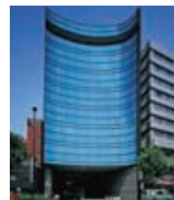
I-32 IKEBUKURO YS BUILDING 池袋YSビル
