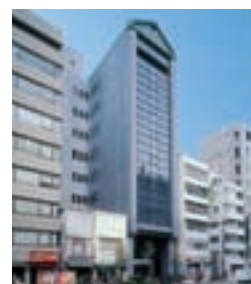
I-10 KODENMACHI SHIN-NIHONBASHI BUILDING 小伝馬町新日本橋ビルディング
