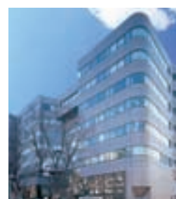
III-2 JOZENJI PARK BUILDING 定禅寺パークビル
