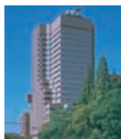
Ⅲ-13 NHK HIROSHIMA BROADCASTING CENTER BUILDING NHK広島放送センタービル
