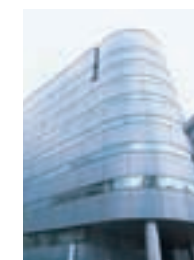
55 NBF博多祇園ビル
