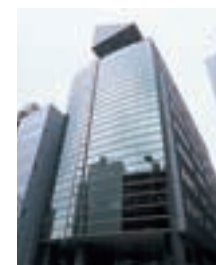
20 住友電設ビル
