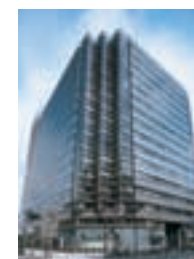
48 堺筋本町センタービル
