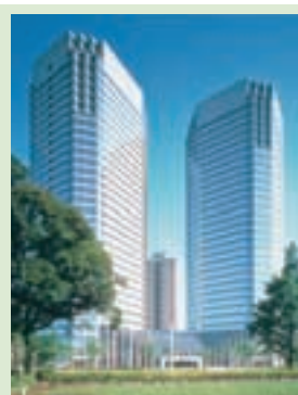
三井不動産グループからの取得物件 新川崎三井ビルディング
