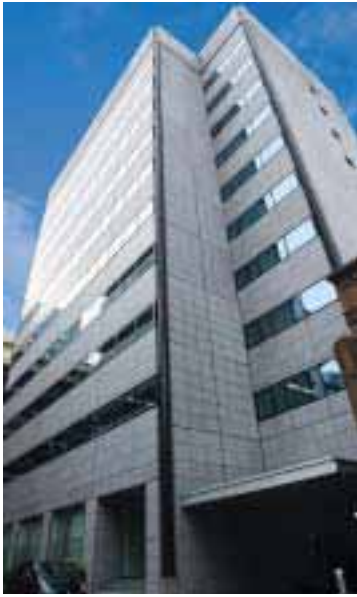
B3 日本橋第二ビル
