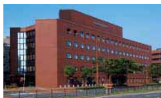
小倉興産 7号館（オフィスビル）
