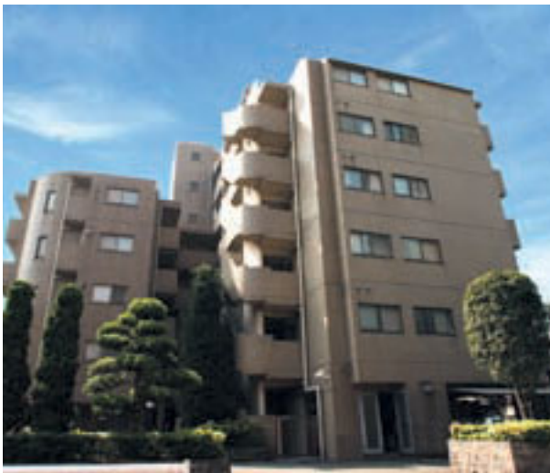
A14 アビタシオンクレール (大田区)
