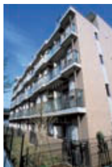
A35 グランリール亀戸 (江東区)
