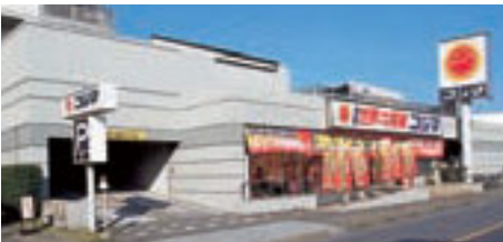
B6 インベリアル東久留米D棟 (東久留米市)
