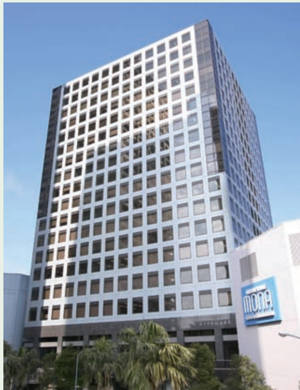
40 新浦安センタービルディング
