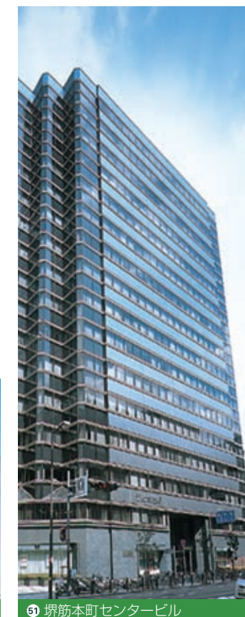
51 堺筋本町センタービル
