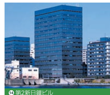
14 第2新日鐵ビル
