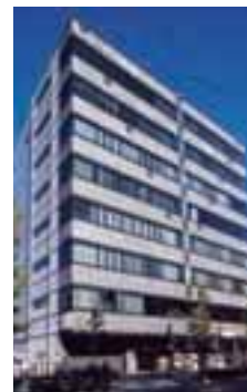
B7 IWATAビル (横浜市)
