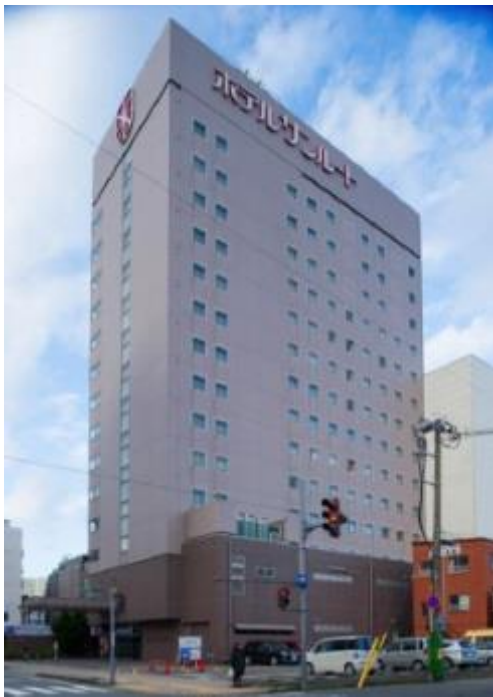
ホテルサンルート新潟 外観写真
