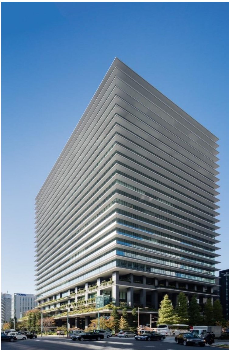
1,000 坪超のフロアプレートと整形無柱空間
