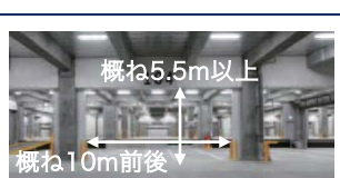
高基準のスペック 保管効率・作業効率の向上を可能とする有効天井高、床荷重、柱間隔
