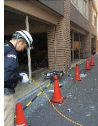
建物点検と緊急安全措置
