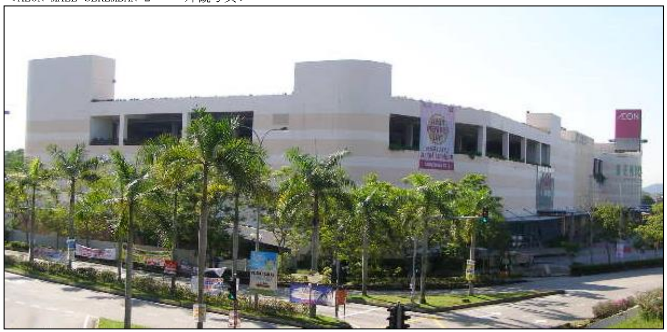
<AEON MALL SEREMBAN 2 外観写真>
