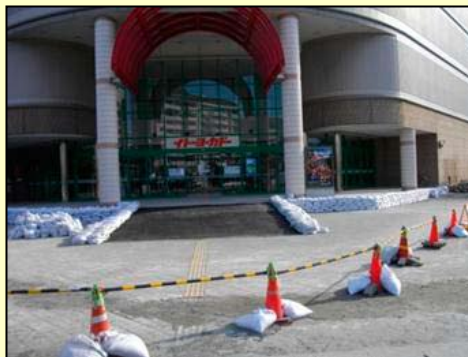
地震後の地盤沈下状況(左) と応急処置後の状況(右)
