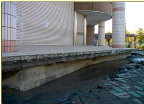
地震後の地盤沈下状況(左) と応急処置後の状況(右)
