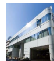
A-28 西新橋三晃ビル
