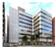
A-13 東池袋センタービル
