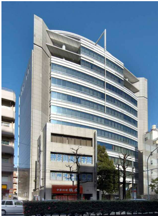
OFC-08 アサヒビルヂング
