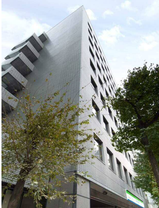
OFC-04 西新宿松屋ビル
