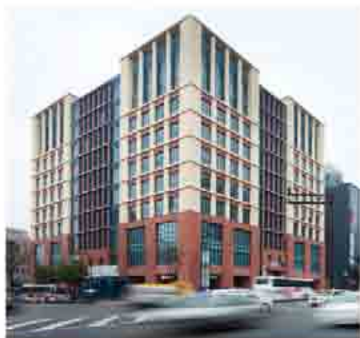
呉服町ビジネスセンター
