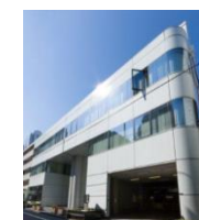
A-28 西新橋三晃ビル
