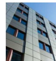
A-23 イトーピア 岩本町ANNEXビル
