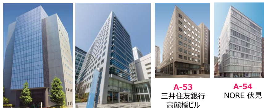
A-51 FORECAST 五反田WEST A-52 大宮センタービル A-53 三井住友銀行 高麗橋ビル A-54 NORE 伏見
