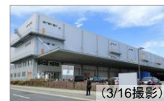
L-4 野田LC 通常稼働 (地震による中断なし)
