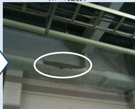
耐火被覆補修後 (耐火充填材にて補修)
