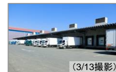
L-9 習志野LC(底地) 通常稼働 (地震による中断なし)
