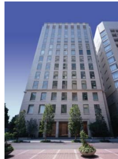
淀屋橋フレックス タワー
