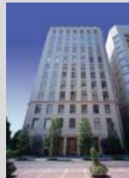
淀屋橋フレックス タワー
