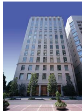
淀屋橋フレックスタワー
