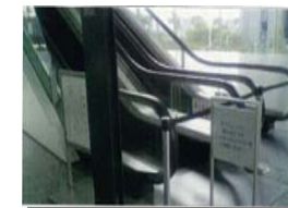
エスカレーターの 日中稼働中止
