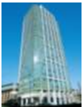
NBFプラチナタワー (東京都港区)
