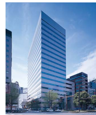
■ 近鉄新名古屋ビル 中部経済圏のエントランスにふさわしいハイグレードな大型ビル
