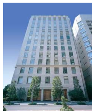
■ 淀屋橋フレックスタワー 大阪のビジネスの中心・淀屋橋に立地するハイスペックな大型ビル
