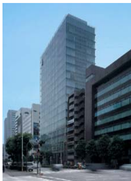
TK南青山ビル
