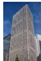
新宿センタービル (東京都新宿区)
