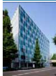
事A-21 JPR千駄ヶ谷ビル
