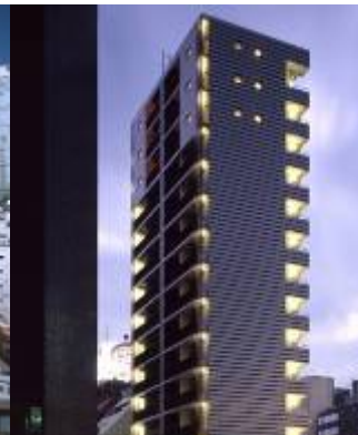
1006 イブセ日本橋 住所：東京都中央区日本橋兜町11番2号 アクセス：東西線茅場町駅より徒歩2分 階数：地下1階付15階建て 建築時期：平成16年11月3日 賃貸可能戸数：51戸（内店舗1戸）
