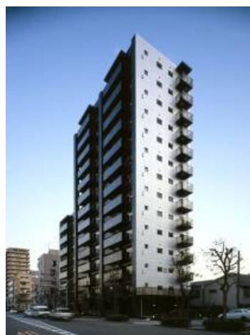
イプセ戸越 所在地／東京都品川区戸越五丁目 総戸数／120戸 構造・規模／鉄骨鉄筋コンクリート造地上14階 交通／都営浅草線「戸越」駅 徒歩4分
