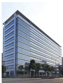
晴海センタービル (東京都中央区)
