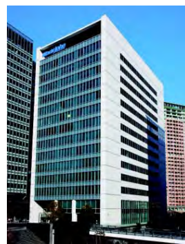
大崎フロントタワー (東京都品川区)
