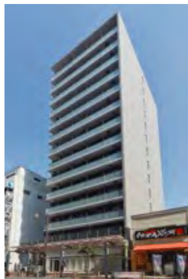
10 江東区亀戸 竣工写真
