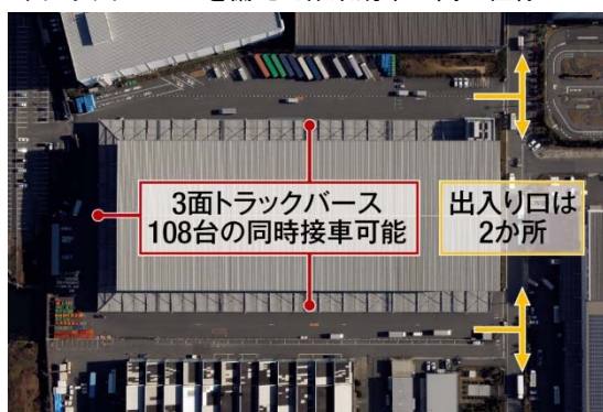
3 面トラックバースを備えた作業効率の高い仕様
