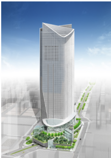
超高層棟全景 (注2)
