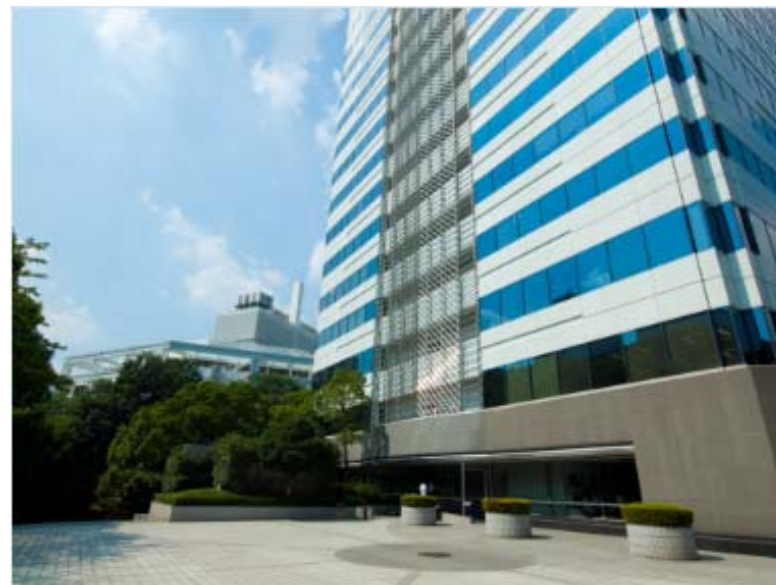
紀尾井町ビル
