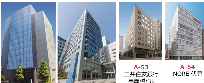
A-51 FORECAST 五反田WEST A-52 大宮センタービル A-53 三井住友銀行 高麗橋ビル A-54 NORE 伏見
