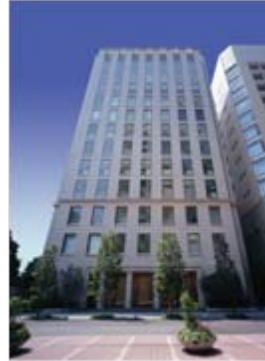
淀屋橋フレックス タワー
